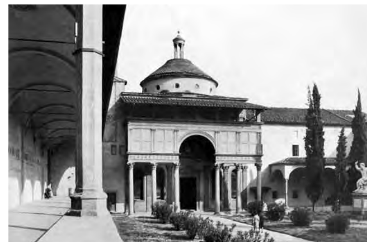
9.2. Exterior de la capilla Pazzi en uno de los claustros de Santa Croce, con el pórtico aparentemente provisional.
