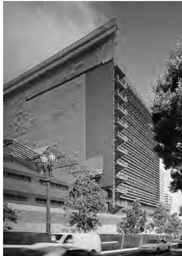
7.1. Sede de Caltrans, Los Ángeles. La fachada corta del edificio está orientada al sur y se ha recubierto con lamas fotovoltaicas de vidrio laminado con células de silicio monocristalino. Fotos: cortesía de Arup.
