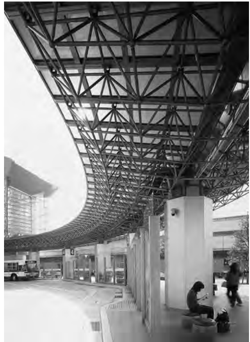
8.1. Estación de autobuses, Kanazawa (Japón): pérgola acristalada con paneles fotovoltaicos de silicio amorfo. Foto: cortesía de Avanzza Japan (véase en color en la lámina X).
