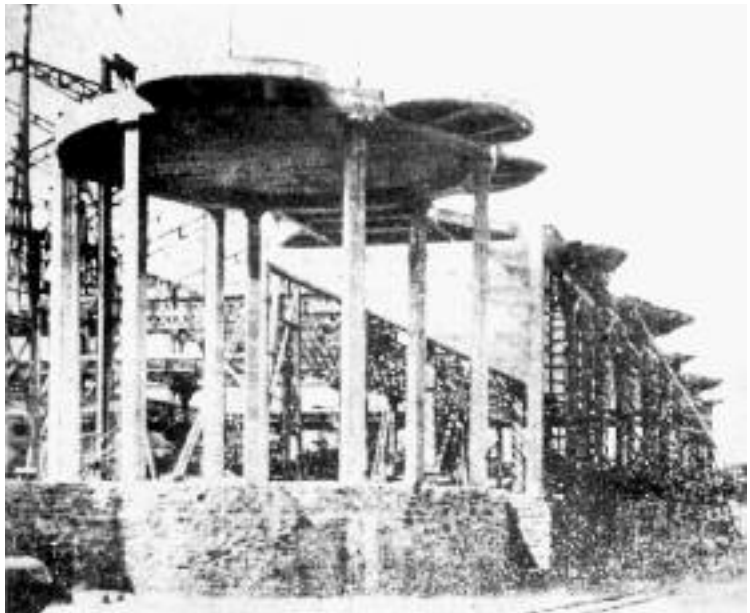
7.1. Estructura de hormigón, Palacio de las Letras, las Ciencias y las Artes, Exposición Universal de París, 1900, obra de François Hennebique. (Reproducido de Tony Garnier, Une cité industrielle ; publicado por Studio Vista; cortesía de Macmillan Inc.)
