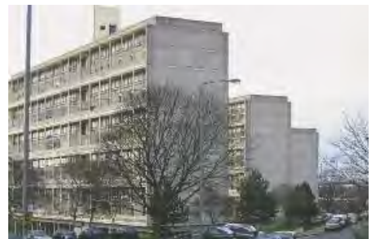
IX. London County Council, viviendas en el barrio Roehampton, Londres, 1965.
