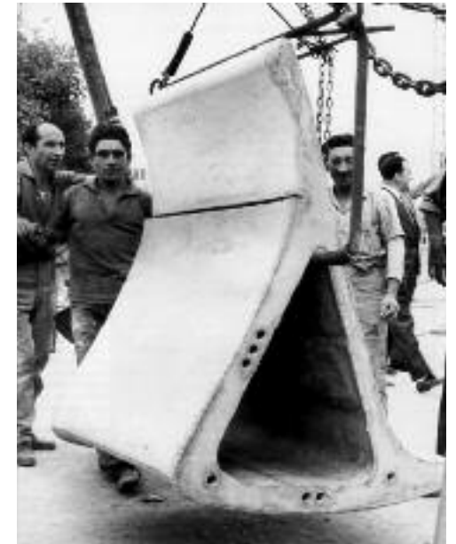
8.1. Algunas realizaciones tempranas en hormigón prefabricado y postensado en España: a la derecha, los 'huesos' de Miguel Fisac; y abajo, la casa Barredo, de Fernando Cassinello.
