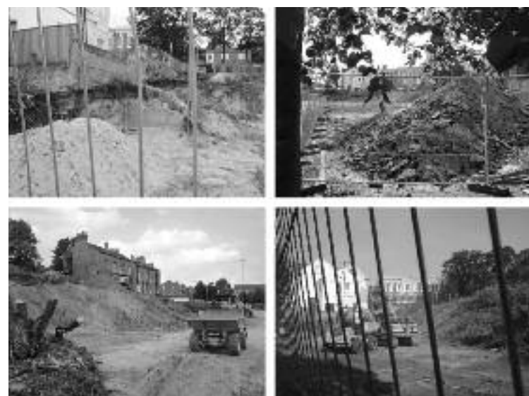
Figura 13.1. La emoción de transformar un emplazamiento abandonado y degradado en un conjunto útil. Reordenación de Peel Street para la Universidad de Nottingham Trent.
