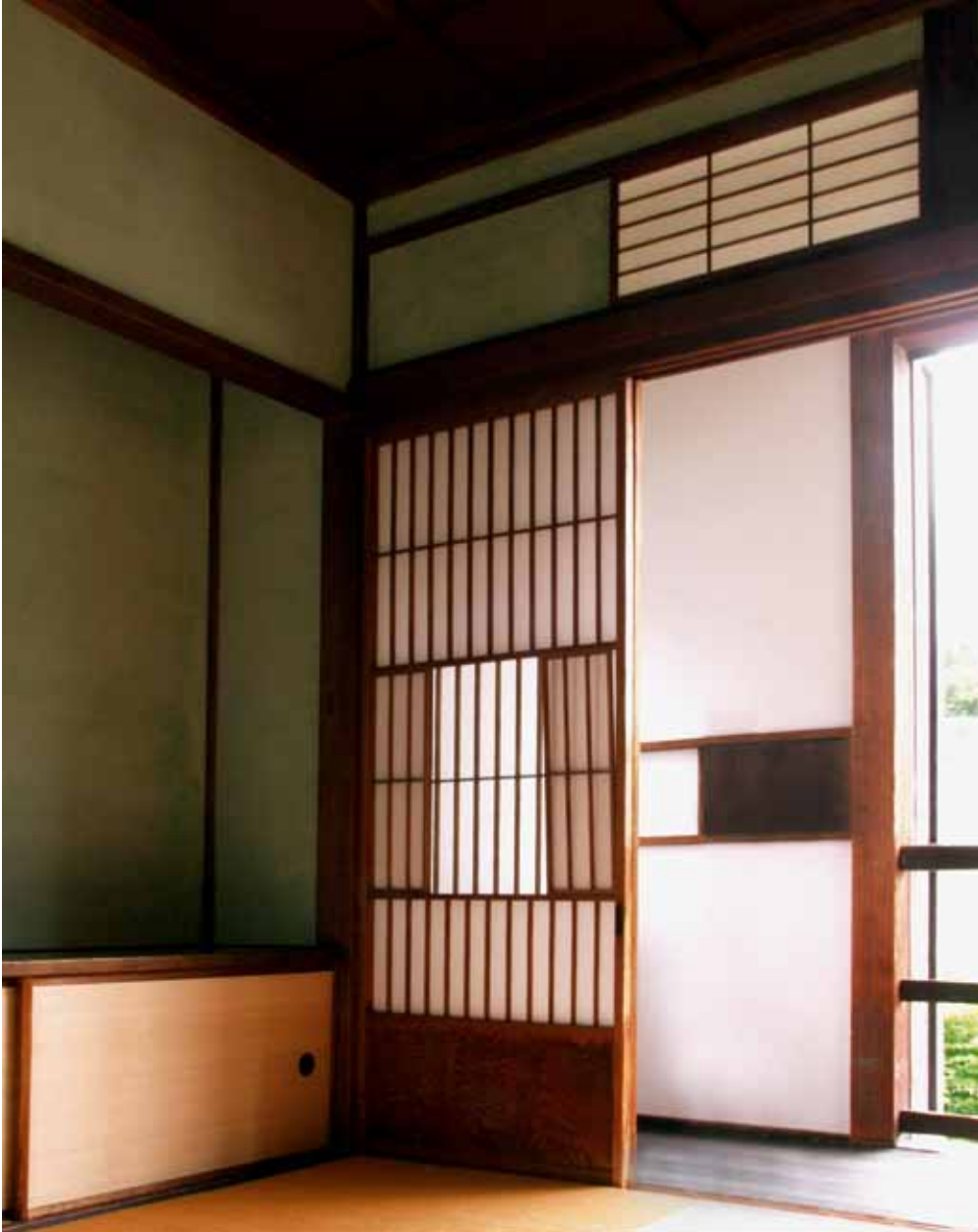
9.1. Akarishōji con una parte central de paneles superpuestos que deslizan lateralmente para tamizar la luz; casa de Koide, Museo de Arquitectura al aire libre Edo-Tokio.
