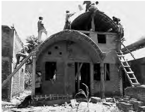
5.1. Sistema de prefabricación popular de bóvedas de ladrillo armado, desarrollado por Carlos González Lobo y utilizado por la ONG ‘Arquitectura y Compromiso Social’ en el barrio de autoconstrucción para maestros en La Dalia (Nicaragua), 1999-2002.
