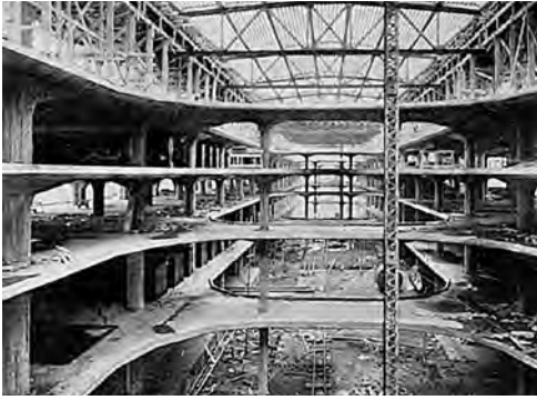
8.20. Obras de construcción de la sala central, con los pozos de luz abiertos en los forjados.
