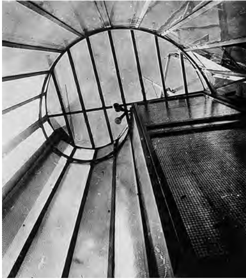
2.30. Vista desde abajo de la escalera de caracol que sube a la azotea; está rematada por un lucernario de hierro y vidrio.
