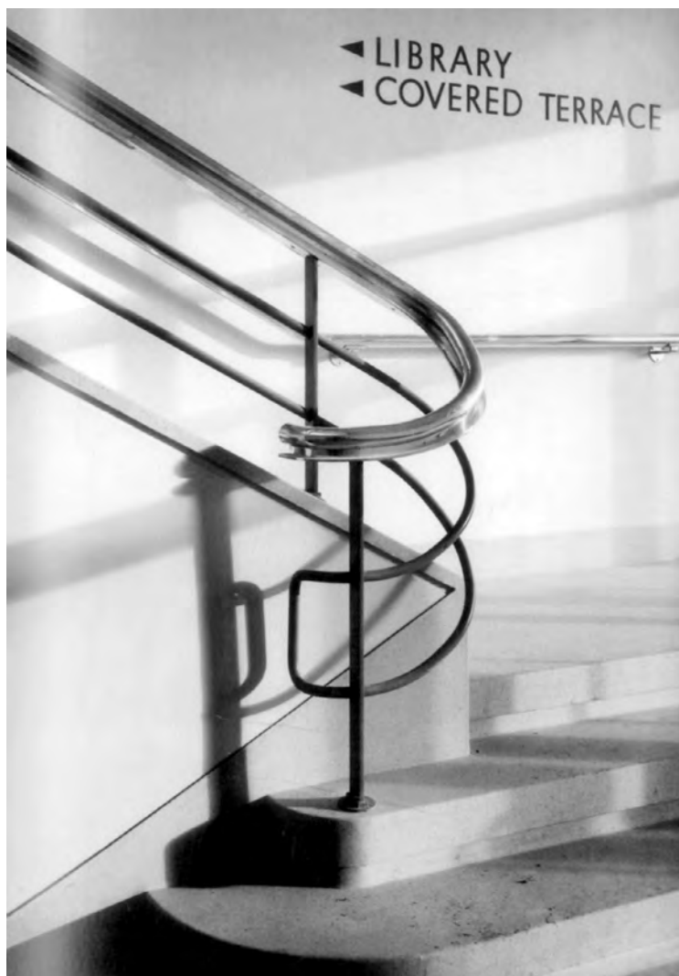
10.24. Detalle de la barandilla en el arranque de la escalera norte.
